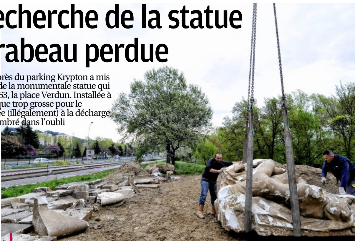
Découverte par hasard, lors des travaux d'agrandissement du parking Krypton, l'allégorie de la France endormie - une des quatre statues qui ornait le piedestal de Mirabeau - a été treuillée par une entreprise spécialisée pour être emmenée dans un dépôt des services du patrimoine. Cette seule pièce pèse une dizaine de tonnes. / PHOTO SOPHIE SPITERI
